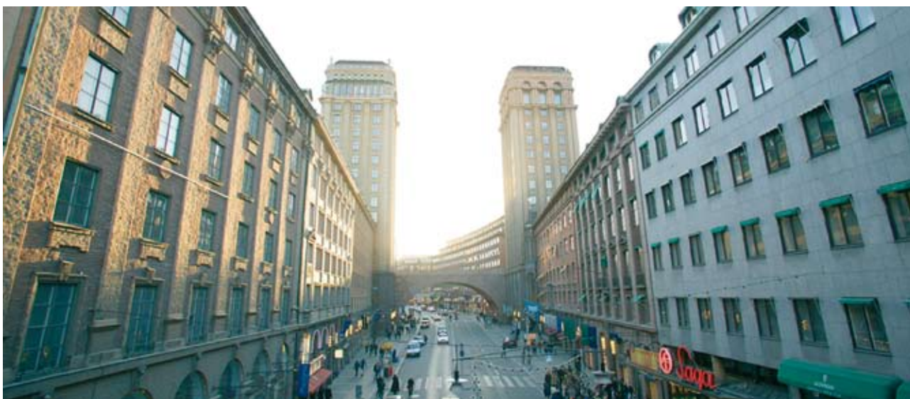
Fabege äger flera fastigheter längs Kungsgatan i Stockholm, t ex Kungstrappan (Stuten 12 och 17) som genomgått en omfattande ombyggnad.
