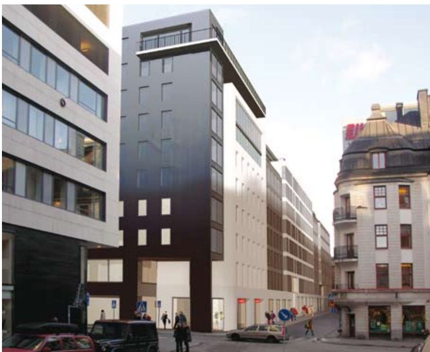
Under tredje kvartalet tecknades avtal med Carnegie och Max Matthiessen om förhyrning av 13 500 kvm i Fabeges fastigheter vid Regeringsgatan-Lästmakargatan. Fastigheterna kommer att genomgå en större om- och tillbyggnad. På bilden visas hur den nya fasaden kommer att se ut.
