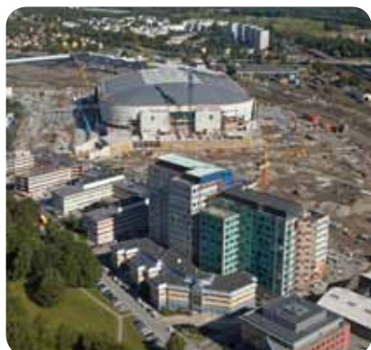
Swedbank Arena och Vattenfalls nya huvudkontor växer fram i Arenastaden.
