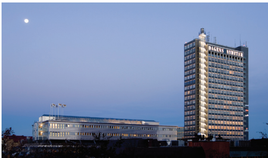
Trängkåren 7 (DN-huset) förvärvades i slutet av året. Fastigheten omfattar en uthyrbar yta om cirka 76 000 kvm, varav 47 000 kvm kontor och 29 000 kvm lager, parkering och övrig yta.
