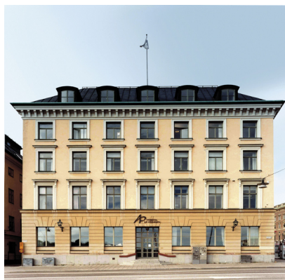
Fastigheten Aeolus 1 i Gamla Stan förvärvades i mitten av februari.
