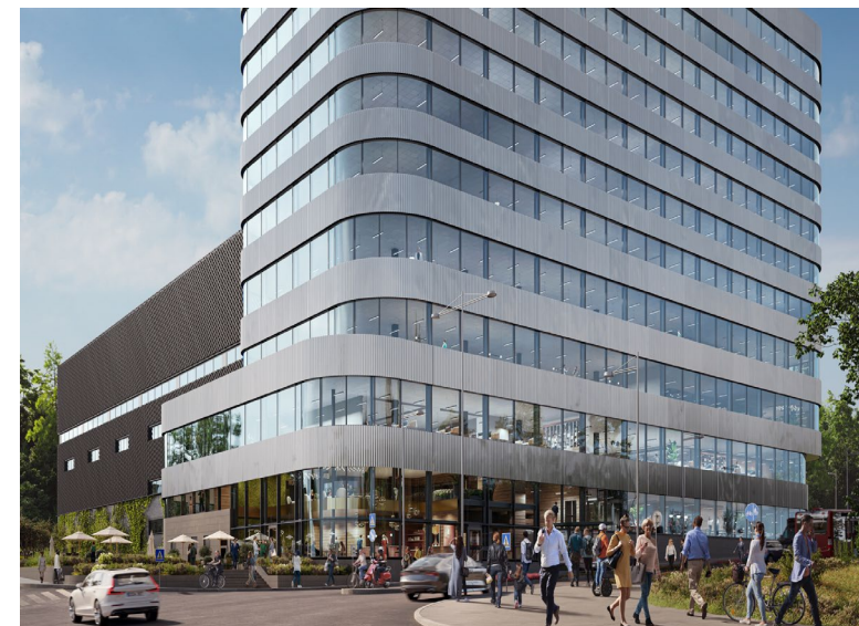
Alfa Laval (Separatorn 1), Flemingsberg
